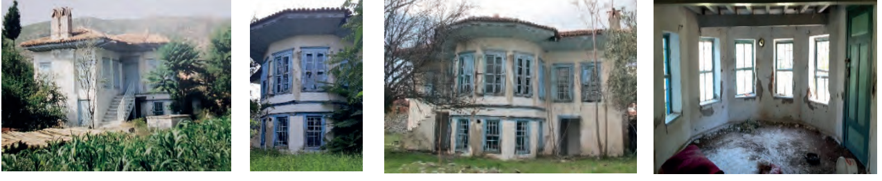
Foto. No. 23-26: Evin yan ve ön cepheleri ile zemin kat sofasından görünümü (Foto. No. 24: Çakırhan, a.g.e., s. 277)
