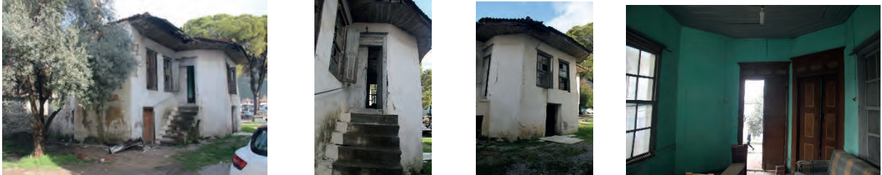
Foto. No. 8-11: Evin bahçe cephesinden, dışrağın yan, ön ve içten görünümü
