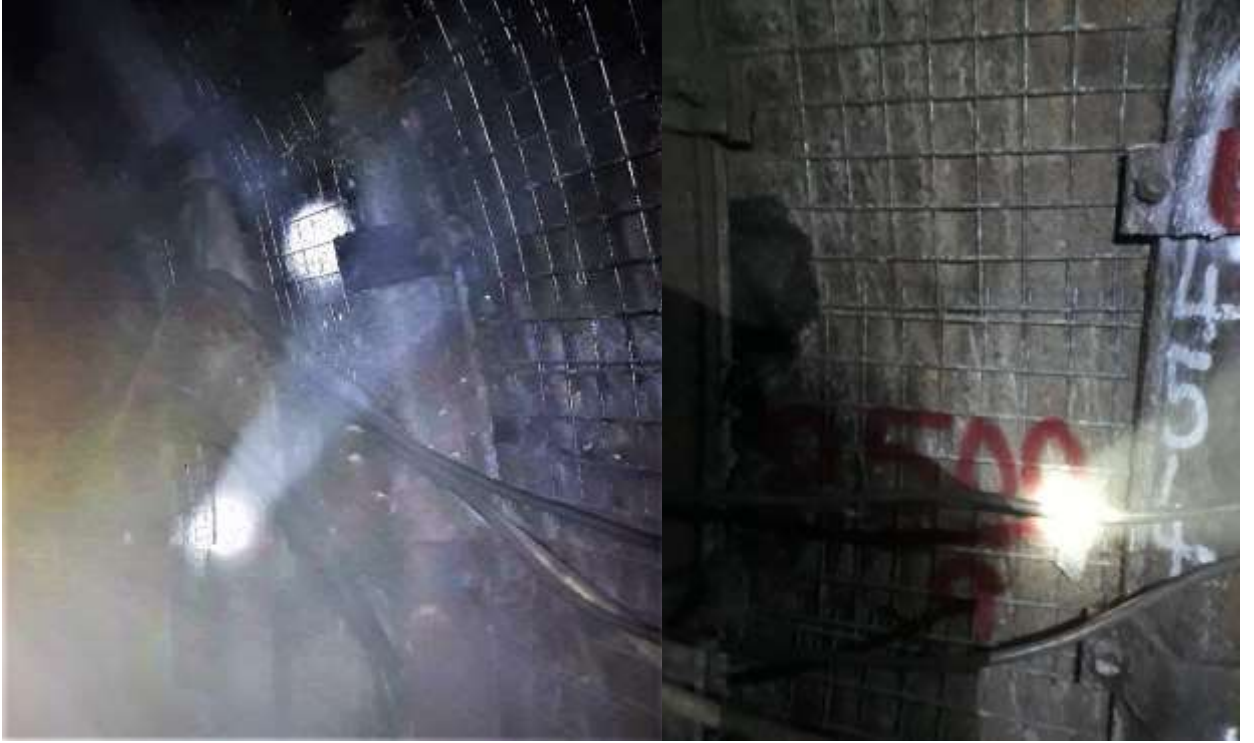
Şekil 6. Tamamlanmış durumda çok katmanlı tahkimat sisteminin galeri içerisinde görünümü
