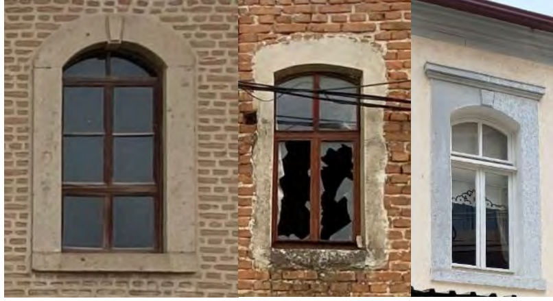
Fotoğraf 22: Giyotin ve Çift Kanatlı Pencere Örnekleri(Hatice Nur Özkan Arşivi,2020)
