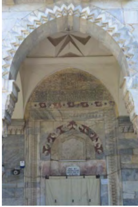
Foto. No.9: Milas Firuz Bey Camii giriş Revakı, Ana Eksen Kemerli ve Taç Kapısının Genel Görünümü
