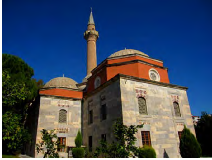
Foto. No.8: Milas Firuz Bey Camii, Güneybatı Cephesi
