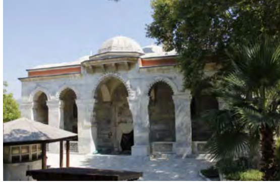
Foto. No.5: Milas Firuz Bey Camii, Kuzey Cephe
