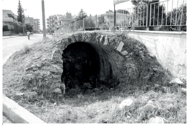
Fig. 12. 3 nolu mezar, batı cephe.
