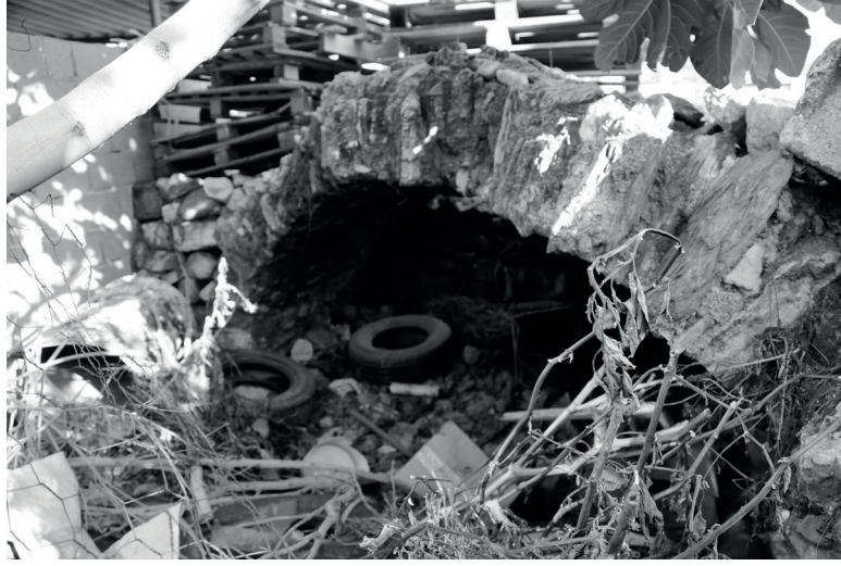
Fig. 19. 7 nolu mezar, batı cephe.
