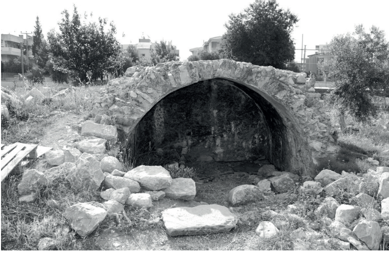
Fig. 4. 1 nolu mezar, batı cephe.
