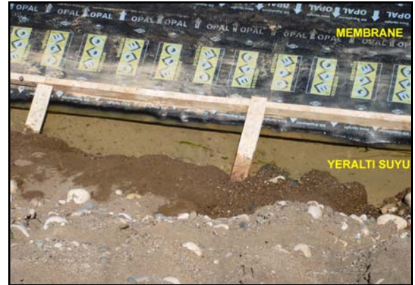
Şekil 7. Yüzeyle oldukça yakın seviyede yeraltı suyunun olduğu bir yüzey kazısı.
